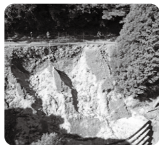
法面が崩壊した林道 湯の谷吉木線
