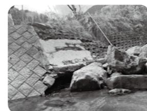
護岸が崩壊した一ノ宮川
