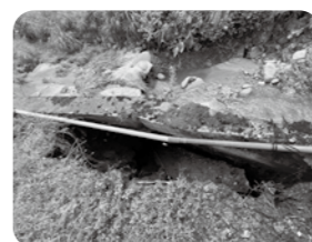
護岸が陥没した一ノ宮川
