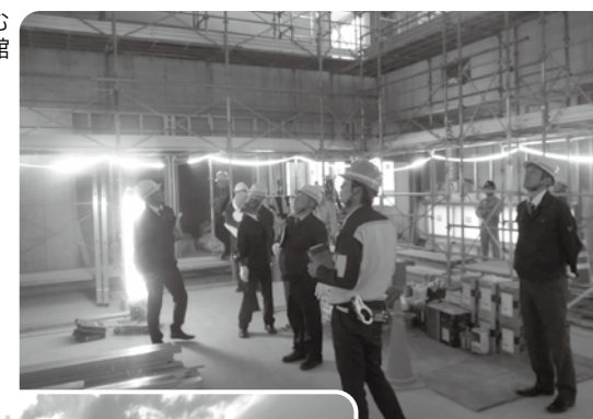
内装工が進む 体育館
