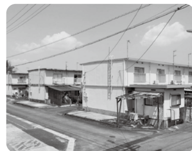
改修が続く町営住宅(真木)
