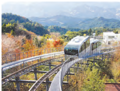
図表 135 スロープカー
