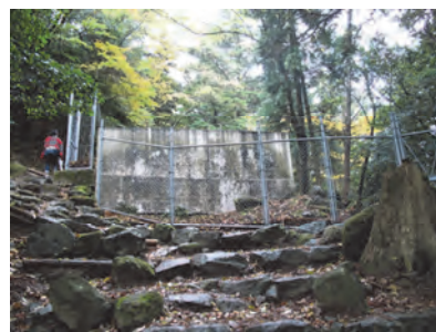
図表 127 消防用水 (英彦山神宮奉幣殿東側付近)
